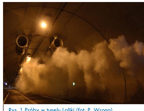
Rys. 1 Próby w tunelu Laliki (fot. P. Wrona)
